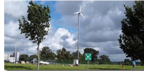
Une **nouvelle éolienne** d'une puissance de 6 kw a été installée au CEI de Saint-Lô, marquant le retour de cette énergie durable au sein de la DIR Nord-Ouest. Couvrant 10 à 15 % de la consommation du CEI, une partie de sa production repart même dans le réseau.
