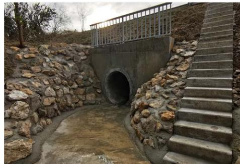
Ce pont est constitué de 3 ouvrages. Les travaux ont consisté notamment à aménager le réseau d'écoulement des eaux, à créer un enrochement latéral pour maintenir le terrain de la tête de l'ouvrage et à créer un escalier d'accès ainsi que la pose d'un garde-corps.
