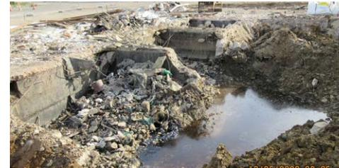
Les mesures de dépollution ont d'abord conduit à l'envoi de 1 820 tonnes de terres et de béton souillés vers un biocentre, en vue d'une traitement par voie biologique évitant ainsi le recours à l'enfouissement et facilitant leur réutilisation ultérieure. Par la suite, ce sont 500 tonnes supplémentaires,
