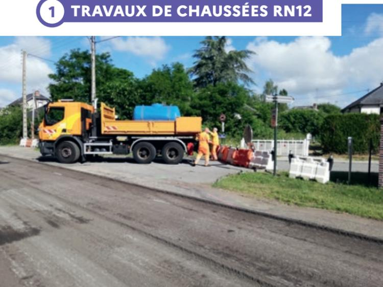
Sur la RN12, la réfection des enrobés entre Mortagne-au-Perche et Alençon a eu lieu, tout d'abord entre Villiers-sous-Mortagne et Saint-Hilaire-le-Châtel sur une distance de 6km puis 7km entre Hauterive et Valframbert.
