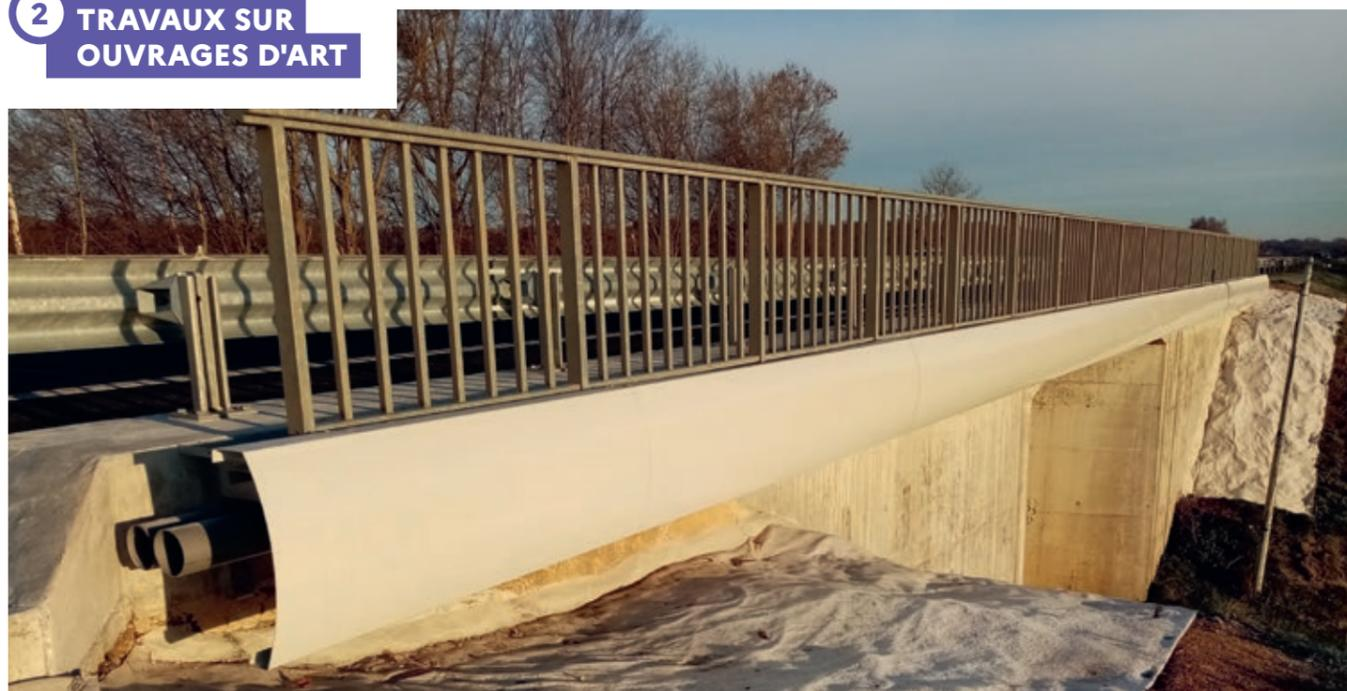
Deux ouvrages d'art de l'A28 ont fait l'objet de travaux de réhabilitation. Les ponts dits de Mesnil et Cruchette ont fait l'objet de remise aux normes des dispositifs de retenue, des corniches et des gardes corps. Le CEI de Maucomble a assuré la surveillance et les opérations de balisage de ce chantier.
