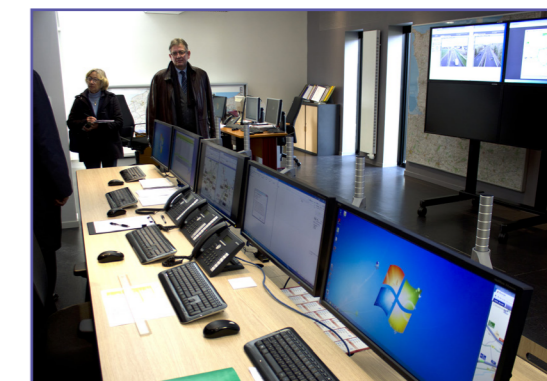
Salle de contrôle du nouveau CIGT de Caen
