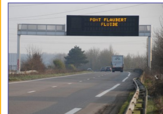
PMV sur A150 permettant d'afficher du temps de parcours
